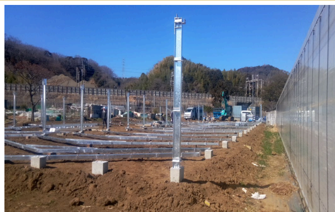
↑新温室工事・基礎工事の様子
