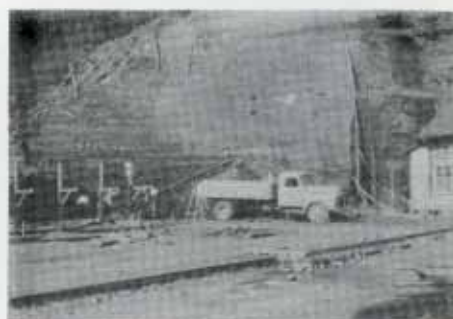
続いて切り崩し 昭和33年
